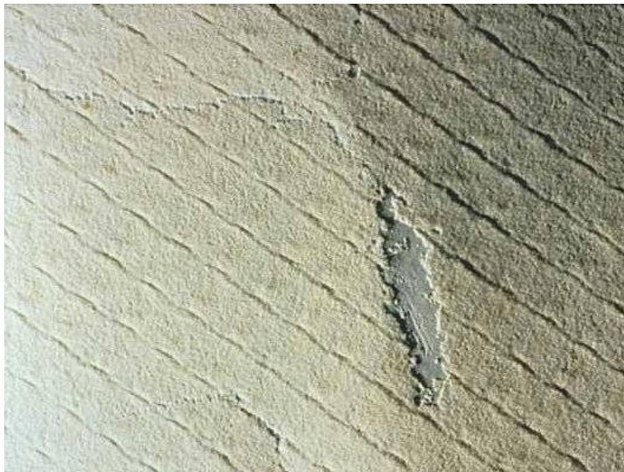
**Correção:** Limpeza ácida; aumento da duração da limpeza ácida
